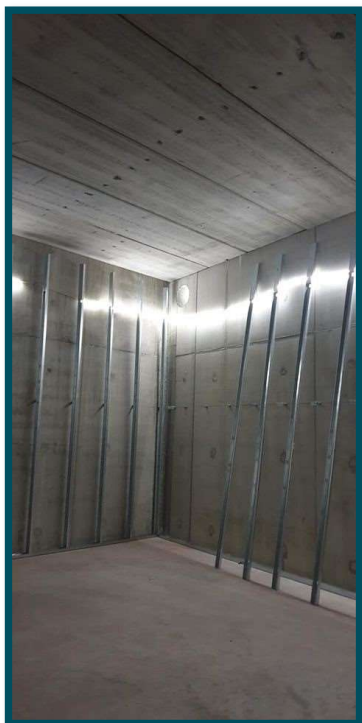
Lydpåforingsvegger er godt i gang
